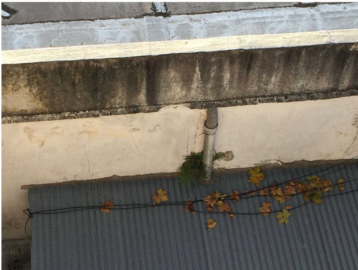
Bajada pluvial a sustituir
