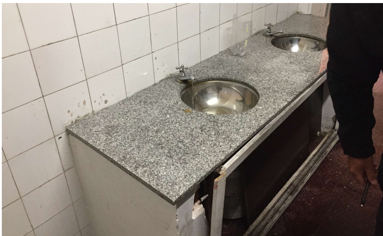
Mesadas a dejar, se eliminan puertas y se revisten pilastras
