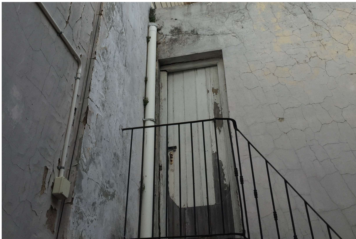
Bajada pluvial a sustituir
